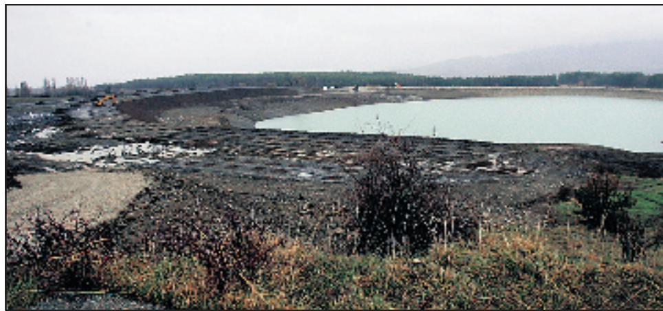
Les travaux ont été réalisés en queue de la réserve pour éviter tout risque de fuite. On aperçoit les fosses de végétalisations destinées à piéger l'eau et les graines. Photo VIRGILE
