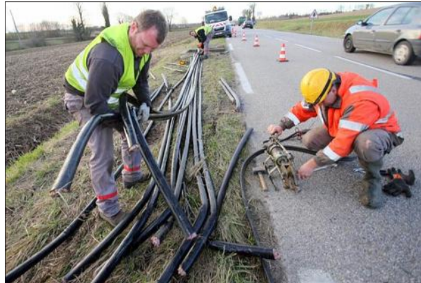
Au-delà du préjudice, le vol de câbles prive notamment les habitants d'un accès immédiat aux divers services d'urgence. Archives photo Le DL.
